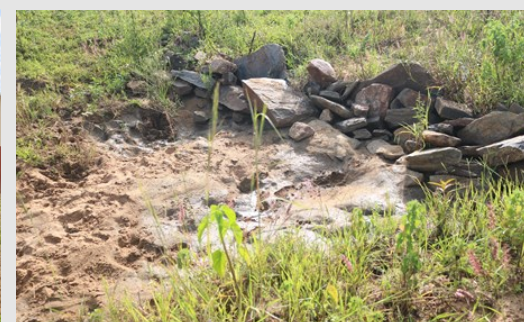
Diguettes filtrantes à Kandi
